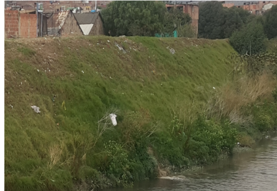
Fotografía 5 Vertimiento evidenciado en operativo del 12/04/2016.
